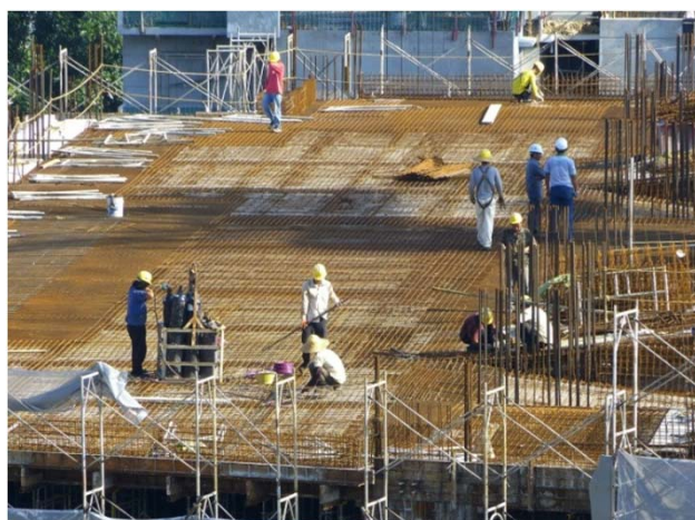
工事現場 構内放送
